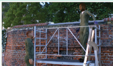
Il y a des réparations à faire sur ce mur, il va falloir remplacer les briques qui manquent.
