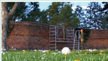
Karim et Diouf sont chargés de la réfection d'un mur pour leur chantier d'insertion.
